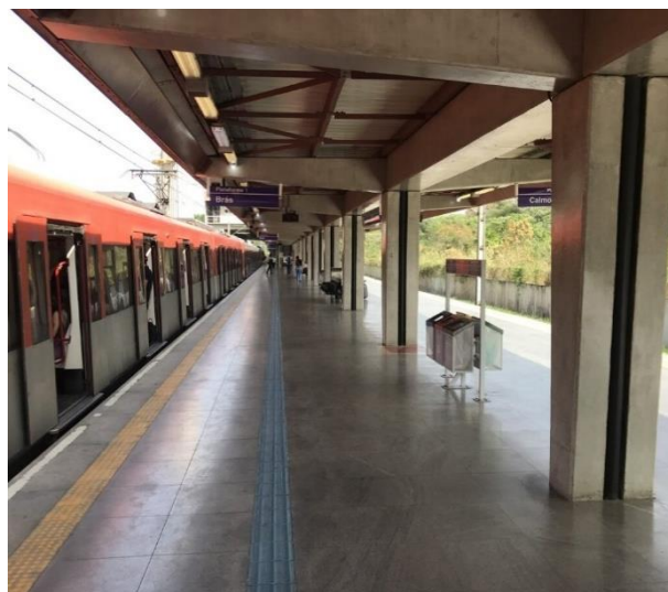
Figura 100 – Rota tátil e sinalização na plataforma
