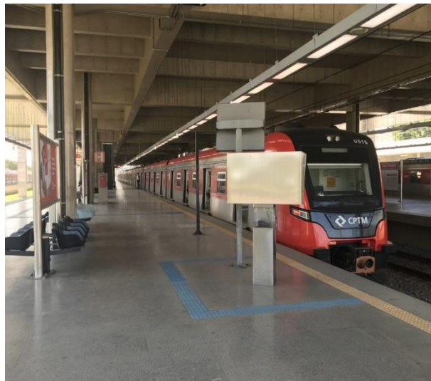
Figura 95 – Rota tátil e sinalização na plataforma
