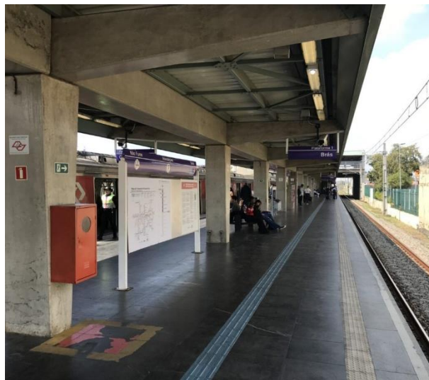
Figura 115 – Rota tátil e sinalização na plataforma
