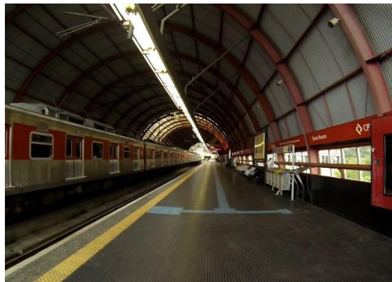
Figura 33 – Rota tátil e sinalização na plataforma
