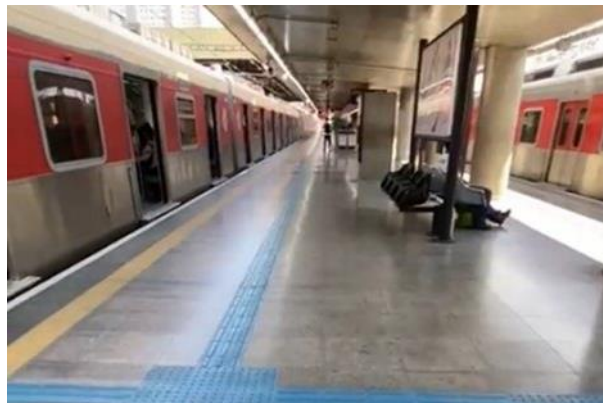
Figura 43 – Rota tátil e sinalização na plataforma
