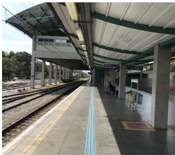
Figura 105 – Rota tátil e sinalização na plataforma
